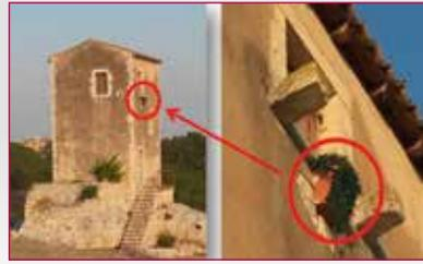
Fig. 5 - Esempio di installazione di Small cell LTE - 4G in una delle finestre del mulino spagnolo -- Parco archeologico della Neapolis.
