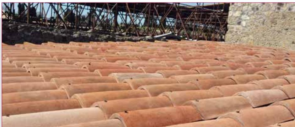
Fig. 4 - Installazione del Coppo Fotovoltaico nel Parco Archeologico di Pompei presso la Casa dei Vetti realizzato nel 2018.
