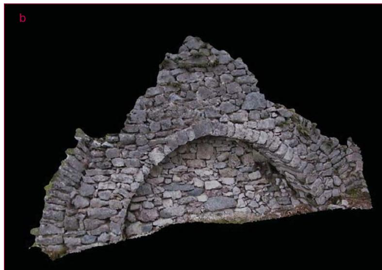
Figura 4 - Modello 3D della parete orientale dell'edificio dopo il restauro (a) e prima di tale intervento (b): nel secondo caso, utilizzando immagini d'archivio, è possibile individuare chiaramente gli elementi originari.
