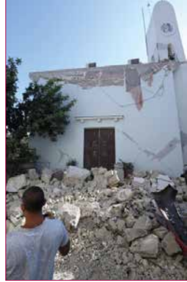
Fig. 2 - Veduta laterale della Chiesa del purgatorio nel Comune di Casamicciola Terme a Ischia con evidenze dei danni subiti a seguito del terremoto del 21 agosto 2017 (Fonte: http://foto.ilmessaggero.it/italia/il_terremoto_e_i_beni_culturali_di_ischia-2630024.html ).
