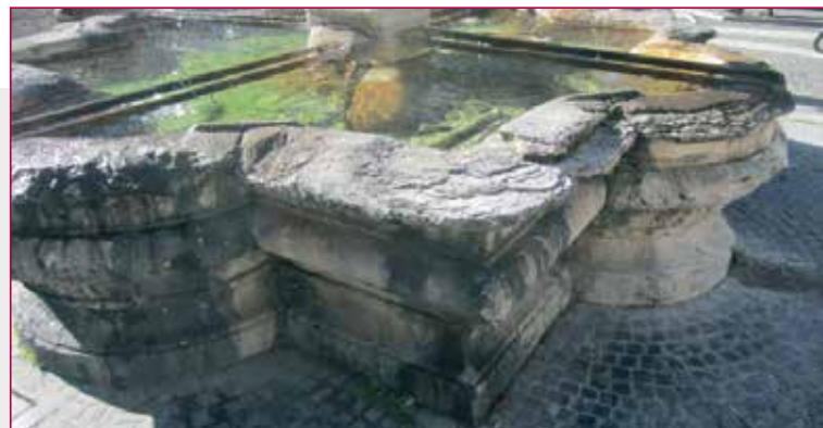
Fig. 3 - Dettaglio dello stato di degrado del bordo.
