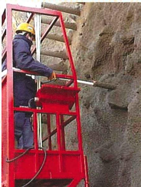
Fig. 6 - Il geo-radar nel controllo di elementi costruttivi. (<http://georadar.ids-spa.it>)
