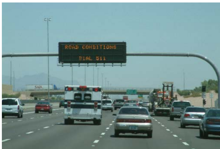
Figura 5: Un esempio di Pannello a Messaggio Variabile: la loro utilità è limitata dalla loro collocazione lungo l'infrastruttura stradale.
