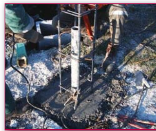
Figura 4: Saldatura dell'armatura al micropalo di fondazione
