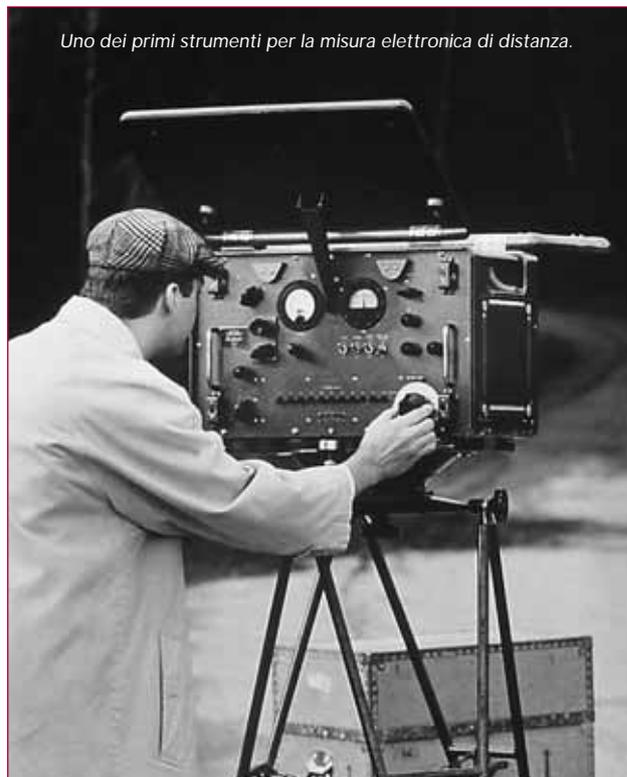
Uno dei primi strumenti per la misura elettronica di distanza.
