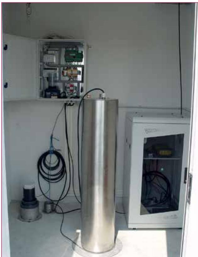
Fig. 2 – Interno della Stazione Mareografica: al centro il sensore mareografici radar, a destra l'armadio con il ricevitore NET-G3.
