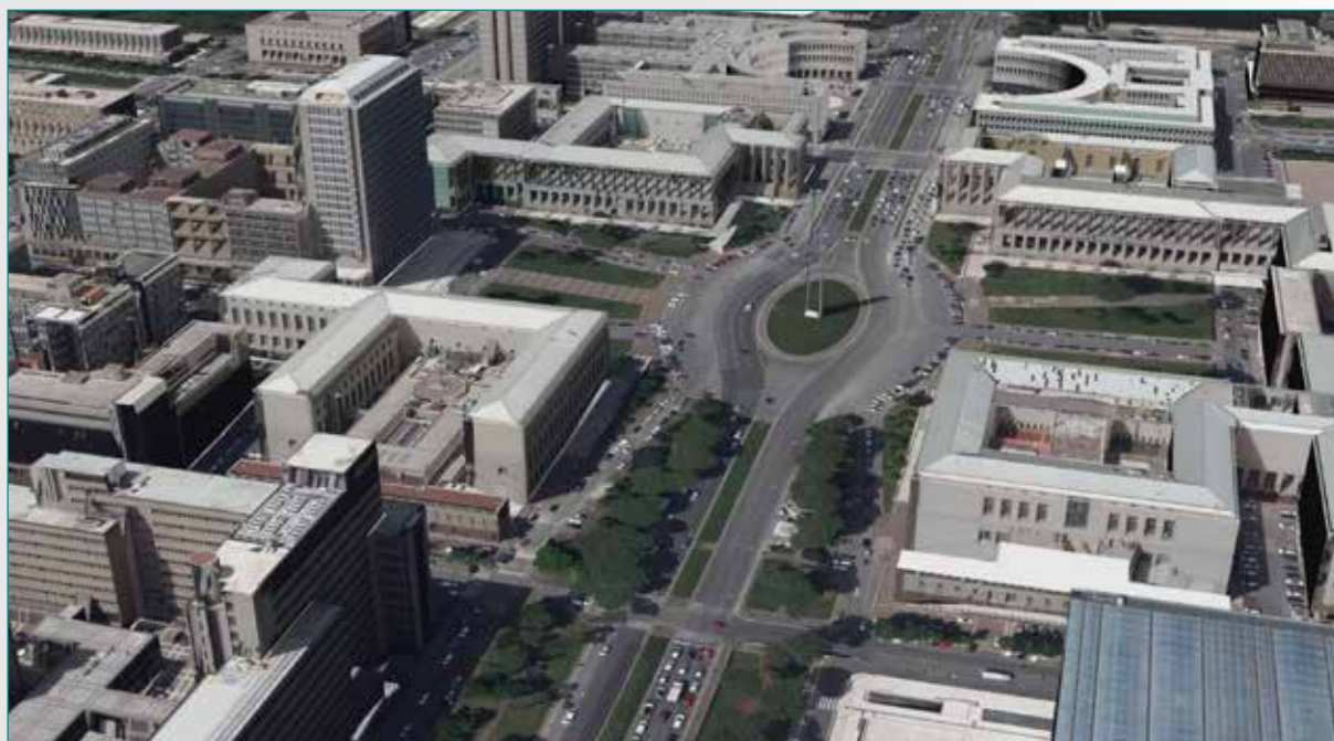
Vista del quartiere EUR di Roma dall'alto, nell'ambito del test di realizzazione del 3DCity per il Digital Twin della città di Roma.
