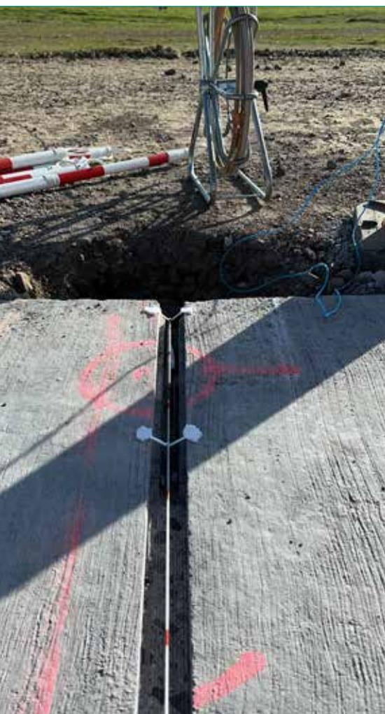
Dettaglio fibra ottica nella trincea scavata nella lastra della pavimentazione dell'aeroporto Charles De Gaulle
