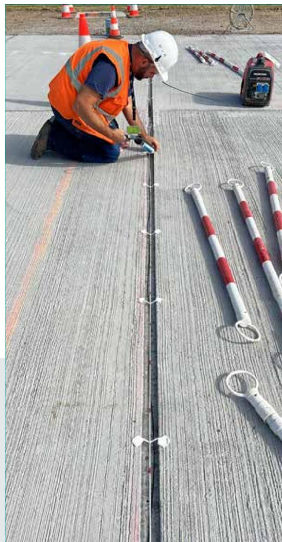
**Tecnico NTSG posa la fibra ottica nella trincea scavata nella lastra della pavimentazione dell'aeroporto Charles De Gaulle**
