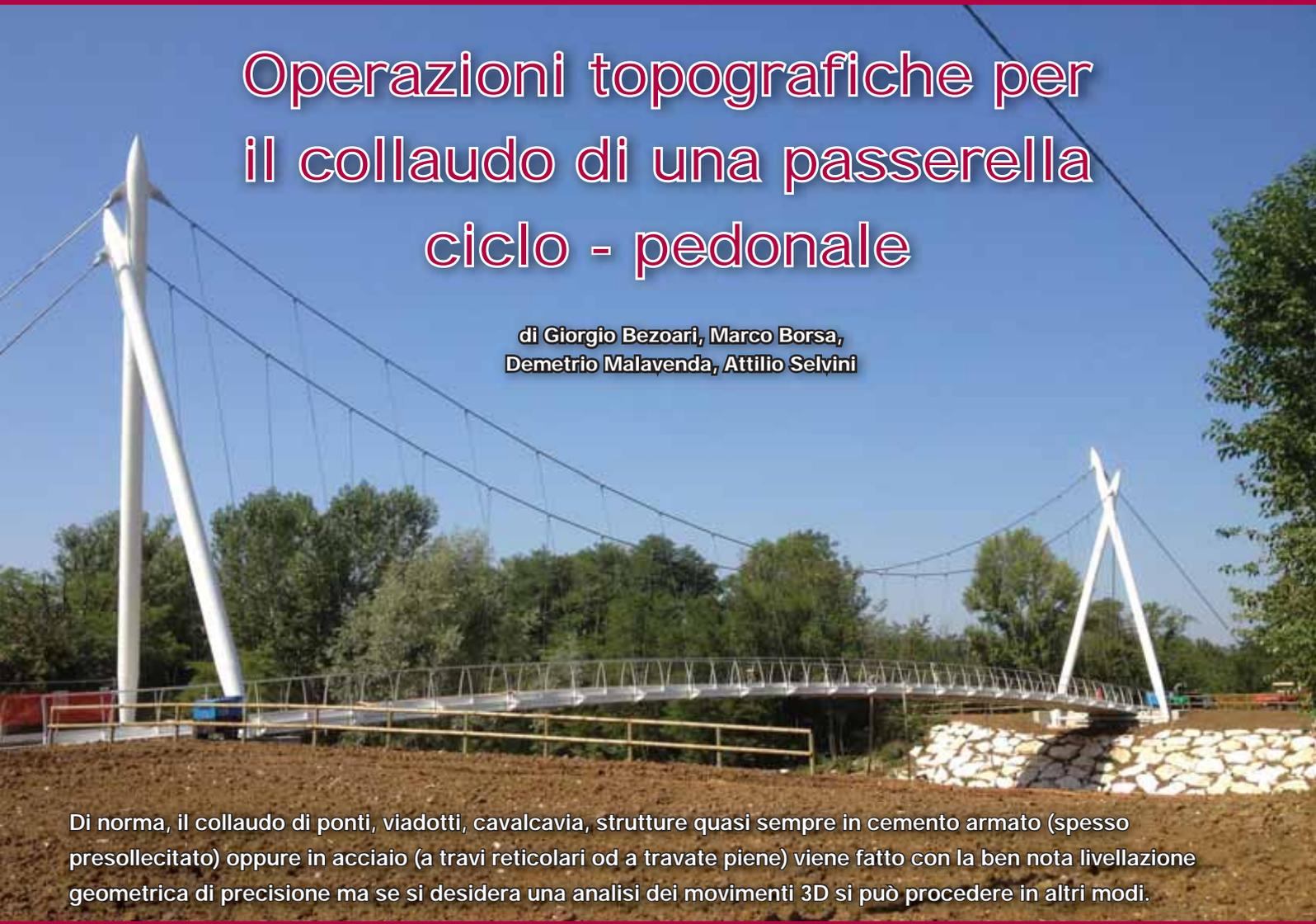
Di norma, il collaudo di ponti, viadotti, cavalcavia, strutture quasi sempre in cemento armato (spesso presollecitato) oppure in acciaio (a travi reticolari od a travate piene) viene fatto con la ben nota livellazione geometrica di precisione ma se si desidera una analisi dei movimenti 3D si può procedere in altri modi.
