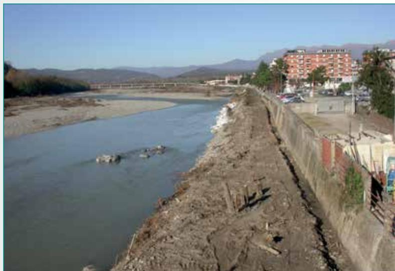
Fig. 6 e 7 - Immagini della piana alluvionale del Fiume Magra nel tratto adiacente all'abitato di Aulla, riprese rispettivamente da valle e da monte. La porzione di abitato sviluppatasi dopo gli anni '50, venne realizzata sull'area golenale del fiume ed è in una condizione di rischio idraulico molto elevato. Foto Archivio ISPRA.
