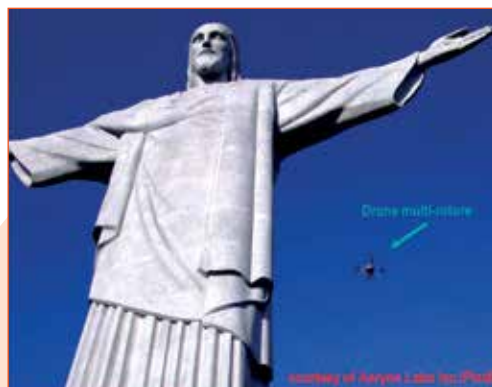
Fig. 3 - Il rilievo di prossimità per immagini (Cristo Redentore a Rio de Janeiro, da Pix4D).
